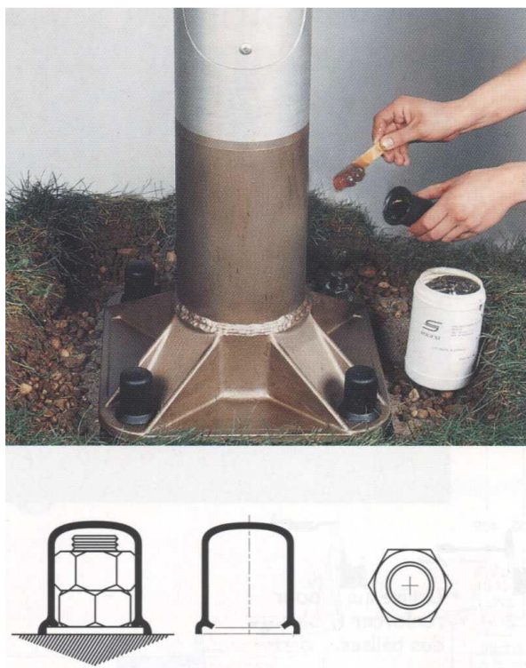
Figure 6 : traitement à la base des candélabres
