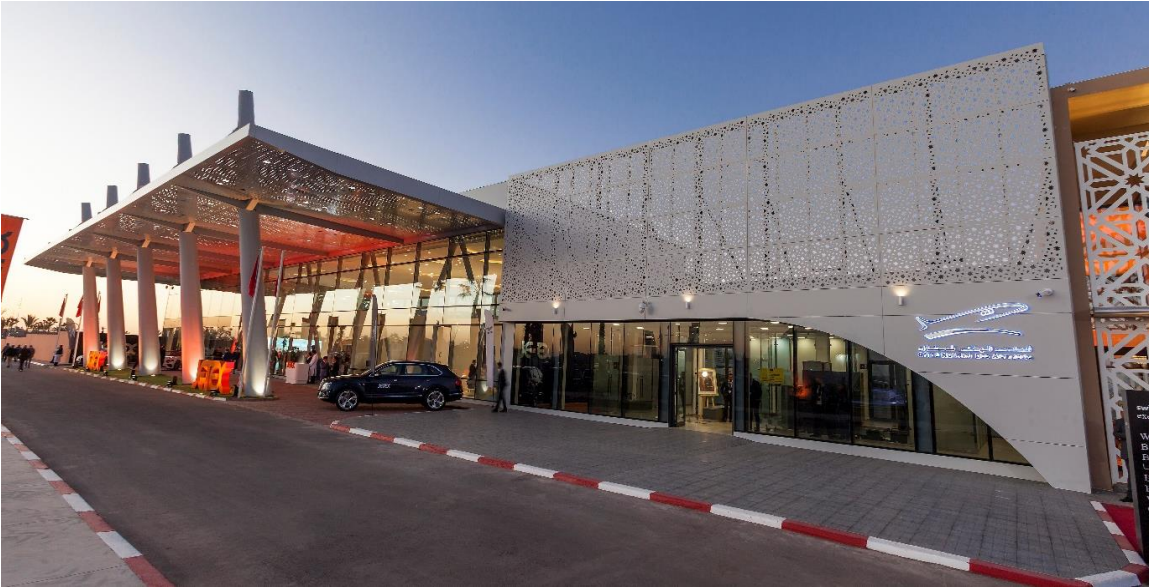
الواجهة الخارجية للمحطة الجوية الجديدة للطيران الخاص بمطار مراكش
